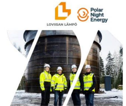
Loviisan Lämpö 1 MW / 100 MWh
